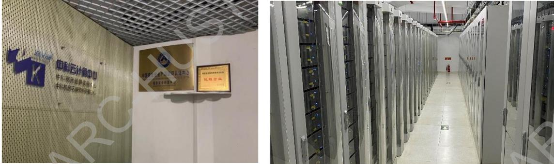
北京中科云数据中心位于北京中关村海淀新技术大厦，毗邻北京大学、硅谷电子一条街，目前主要做民用、商用等超算，数据中心共有机架315个，单机架功率为7-15kW。数据中心周围有办公室和住宅区。2014年以前，使用水冷螺杆机进行制冷，噪音太大，投诉很多，改用磁悬浮离心机组后，噪声大大降低。
